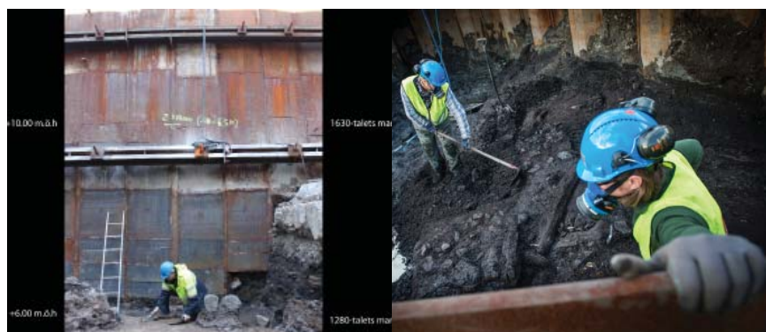
Figur 5 och 6. Två exempel från den stadsarkeologiska arbetssituationen idag. T.v. Arbeta invid en spontan schaktkant med avsevärda nivåskillnader från Södermalmstorgsundersökningen i Stockholm. Foto: Arkeologikonsult. T.h. Arbeta i full skyddsmundering med förorenade kulturlager från undersökningarna av Nya Lödöse, Göteborg. Foto: Markus Andersson/ Staden Nya Lödöse.
