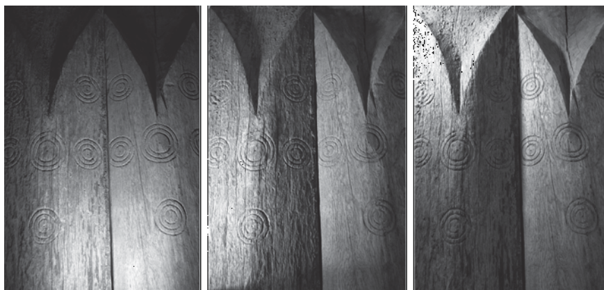
Figur 13. Bilder på ett par sammanställda väggstavar i olika ljussättning. Den märkliga stavkyrkoväggen väcker frågor om stavkyrkobyggarnas gestaltningsidé och associationer. Det finns en uppenbar likhet med de lika märkliga "fiskhuvudformade" hängena som påträffas som gravfynd på Gotland. Skulle det kunna vara så att gestaltningsiden till de tidiga stavkyrkorna är en materiellt traderad tolkning av den bibliska beskrivningen av tabernaklet? I Moseboken ges en detaljerad och intrikat beskrivning av det heliga tabernaklet som en tältkonstruktion "med dess täckelse och alla dess tillbehör, dess häkter, bräder, tvärstänger, stolpar och fotstycken" (Andra Moseboken, kap. 39). Hemse hade jordgrävda väggstavar förankrade i marken och stadgade med stora synliga stenbumlingar. Väggarna lutade svagt inåt och stavarna förkroppade mot marken. Väggstavarnas bågsegment och de skurna krönen ger en textil böljande karaktär. Ringornamentiken utmed väggbandet ter sig som hängen i metall. "Bräderna till tabernaklet gjorde man av akacieträ och ställde dem upprätt. Tio alnar långt och en och en halv aln brett gjordes vart bräde. På vart bräde sattes två tappar, förbundna sinsemellan med en list; så gjorde man på alla bräderna till tabernaklet" (Andra Moseboken, kap. 36). Fotograf: Gunnar Almevik.
