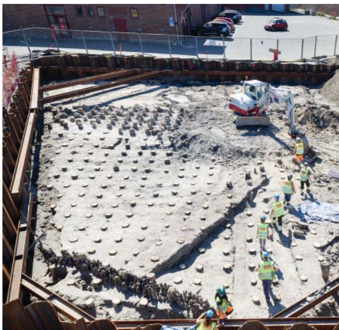
Figur 7. Delar av vallgraven (i bakgrunden) och en palissad (rad av smala pålar i förgrunden) vid undersökningen 2015. De grövre pålarna är grundläggningen till en byggnad från 1900-talets början. Palissaden har daterats dendrokronologiskt till år 1529, efter att Gustav Vasa påpekade behovet av att befästa staden. Foto: Markus Andersson/Staden Nya Lödöse.
