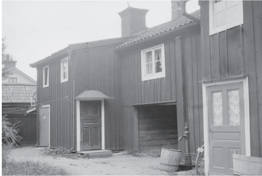
Figur 1. Ågatan 9, ett bostadshus i Linköping, Catharina Bergstedts hem 1759–1817. Husets komplexa plan består av olika historiska lager av byggnation, bruk, reparation, flytt till Gamla Linköping, konkreta spår av människors liv och leverne. Foto Bengt Cnattingius 1929, E004901, Östergötlands museums arkiv.
