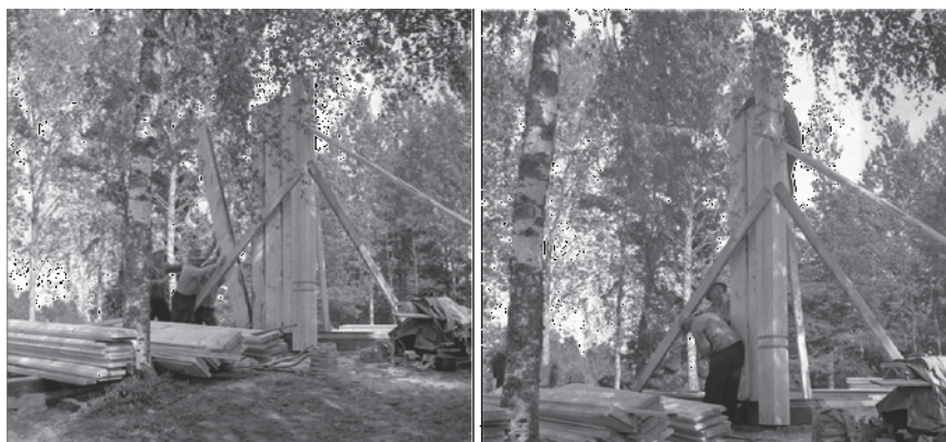
Figur 7. Återuppbyggnad av Skaga kapell i Västergötland 1957. Bygget är småskaligt och utförs av tre till fyra personer. Stavar och band hanteras manuellt med enkla hjälpmedel. Fotograf: Thure Elgåsen /Västergötlands museum.
